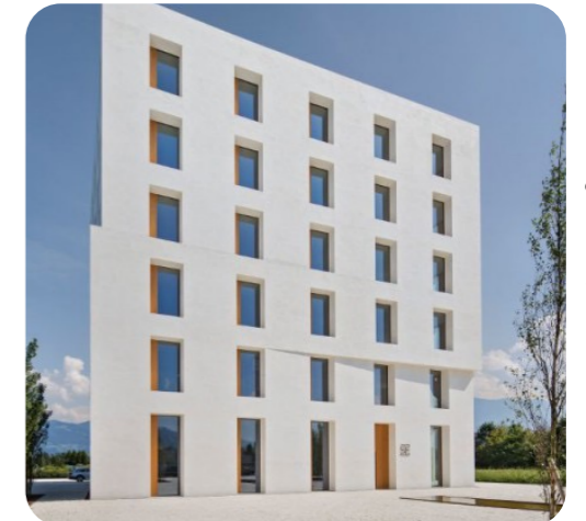
Bâtiment 2226, BE - Baumschlagler eberle, Eduard Hueber
